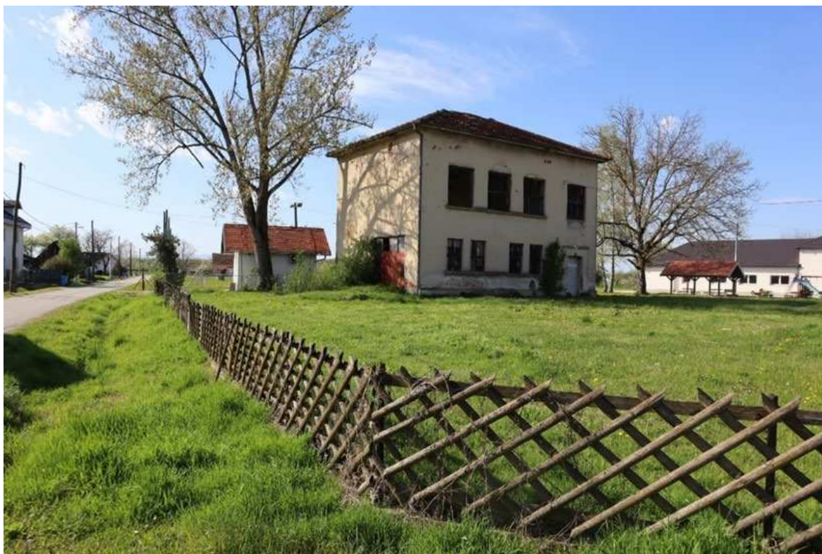
Slika 64 – Zgrada nekadašnje škole u Ježevu (Autor: 3E PROJEKTI d.o.o.)
