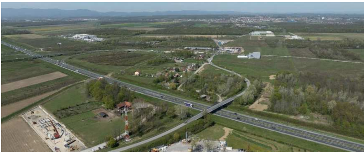
Slika 48 – Pogled na autocestu A3 i Dugoselsku cestu (Autori: 3E PROJEKTI d.o.o. i Andlar)
