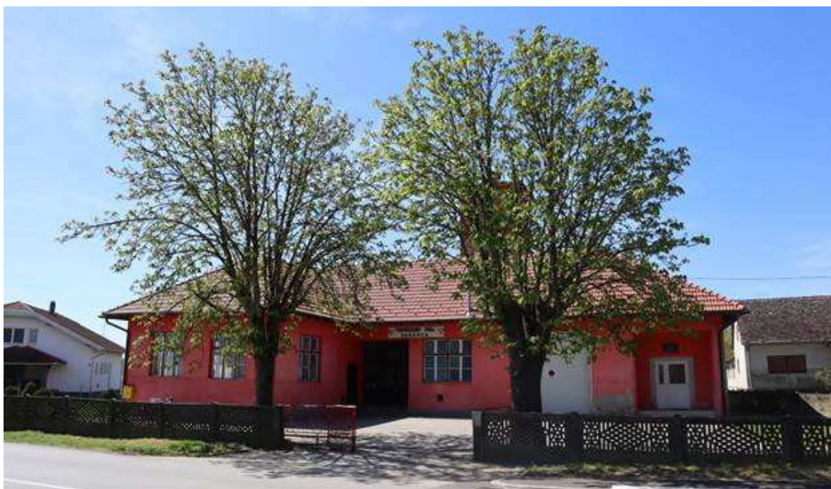
Slika 73 – Pogled na Vatrogasni dom Oborovo (Autor: 3 E PROJEKTI d.o.o.)
