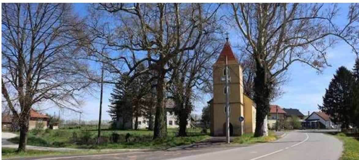
Slika 71 – Površina uz napuštenu zgradu škole i kapelu Majke Božje Žalosne (Autor: 3 E PROJEKTI d.o.o.)
