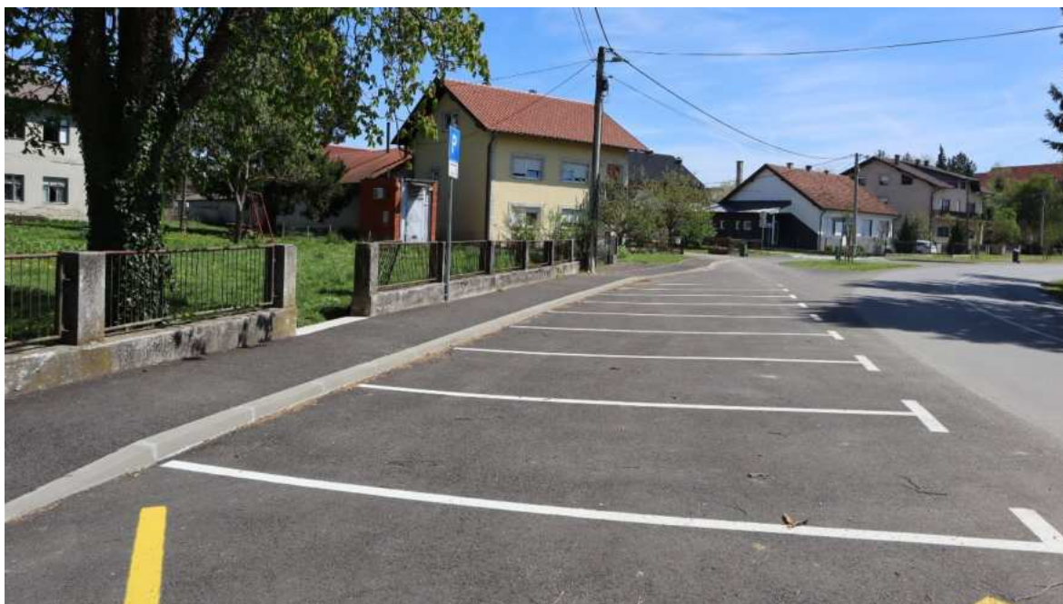
Slika 52 - Parkiralište sklopu crkve Oborovu (Autor: 3E PROJEKTI d.o.o.)
