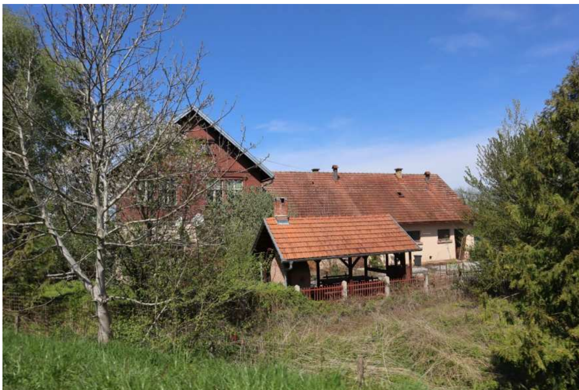
Slika 42 – Pogled napušteni objekt veterinarske stanice (Autor: 3E PROJEKTI d.o.o.)
