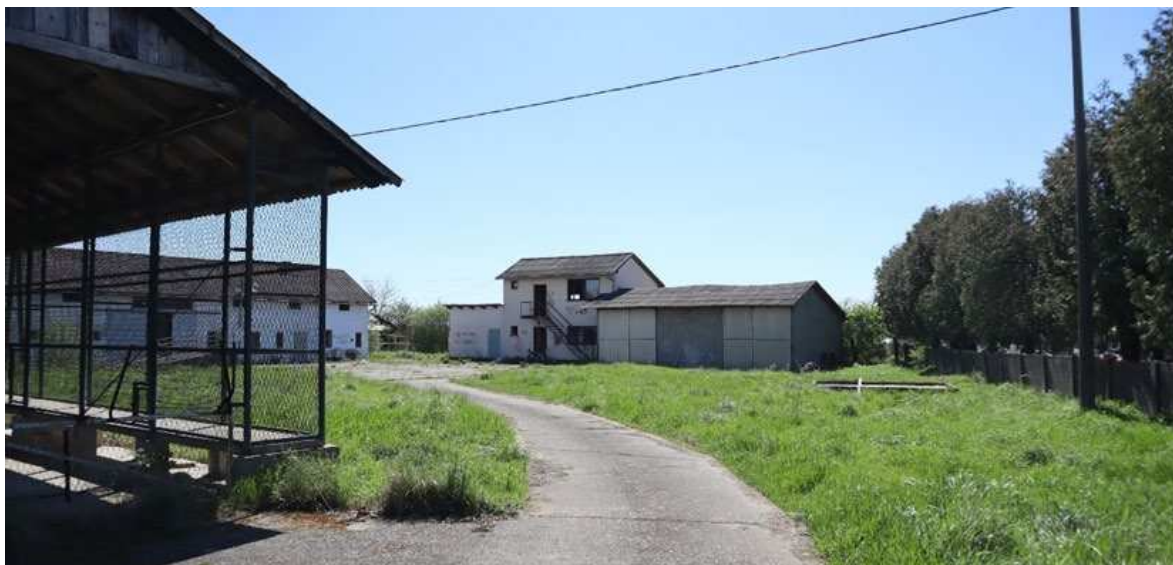
Slika 65 – Napušteni objekti unutar prostorne cjeline kompleksa Crkve Uznesenja Blažene Djevice Marije u Jalševcu Nartskom (Autor: 3E PROJEKTI d.o.o.)
